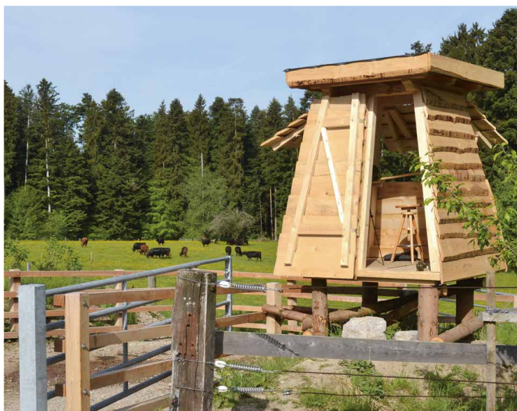
La cabine de tir de 180 × 180 cm se trouve à environ 1,5 m au-dessus du sol. La pièce mesure quelque 200 cm de haut, pour que le tireur puisse se tenir debout. La position de tir se situe à environ 3 m au-dessus du sol. Un tabouret de bar réglable en hauteur fait office de siège.
